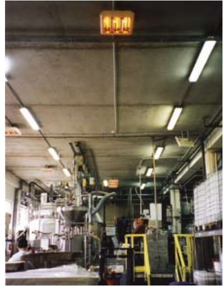
IRCF werden oft in großen Lagerhäusern installiert, da sie für schnelle, effektive und kostengünstige Wärme sorgen
